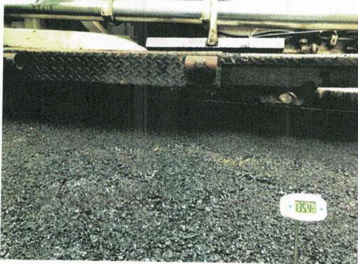
รูปขณะดำเนินการ
